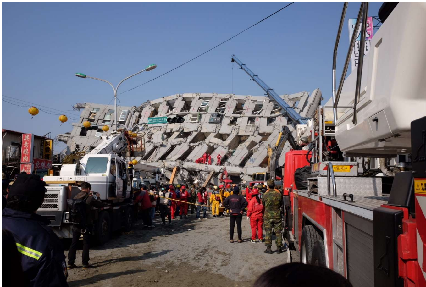
0206地震，臺南維冠大樓災區現場
