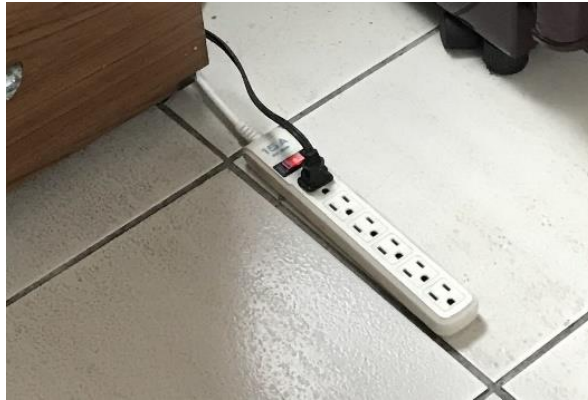
圖 10：使用合格且具安全斷電裝置之延長線(資料來源：本計畫拍攝)
