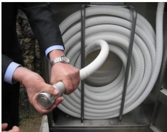
圖 27 第二種室內消防栓
