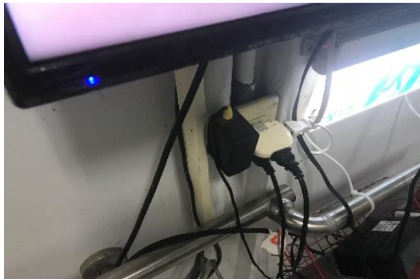
圖 11：延長線過度串接(資料來源：本計畫拍攝)
