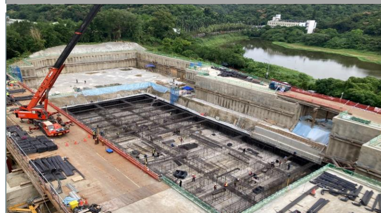
現代化食品藥物國家級實驗大樓暨行政及訓練大樓施工中
