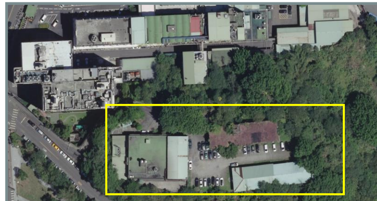
現代化食品藥物國家級實驗大樓暨行政及訓練大樓施工前
