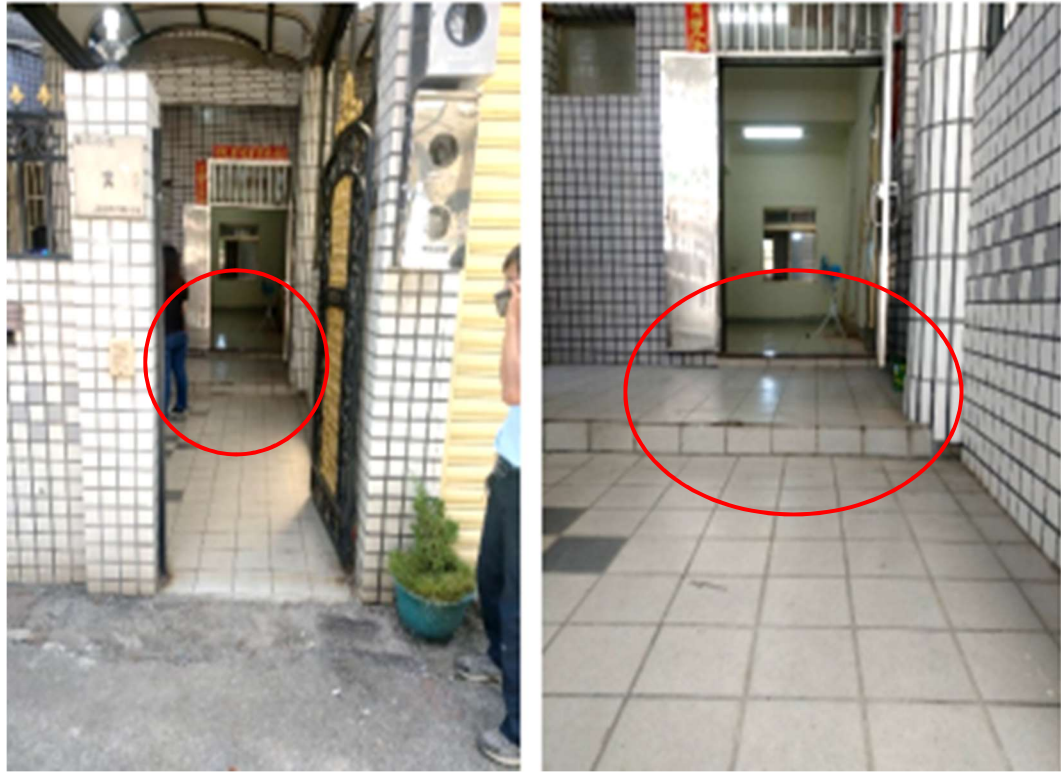
▲ 主要出入口及玄關 (修繕前)
