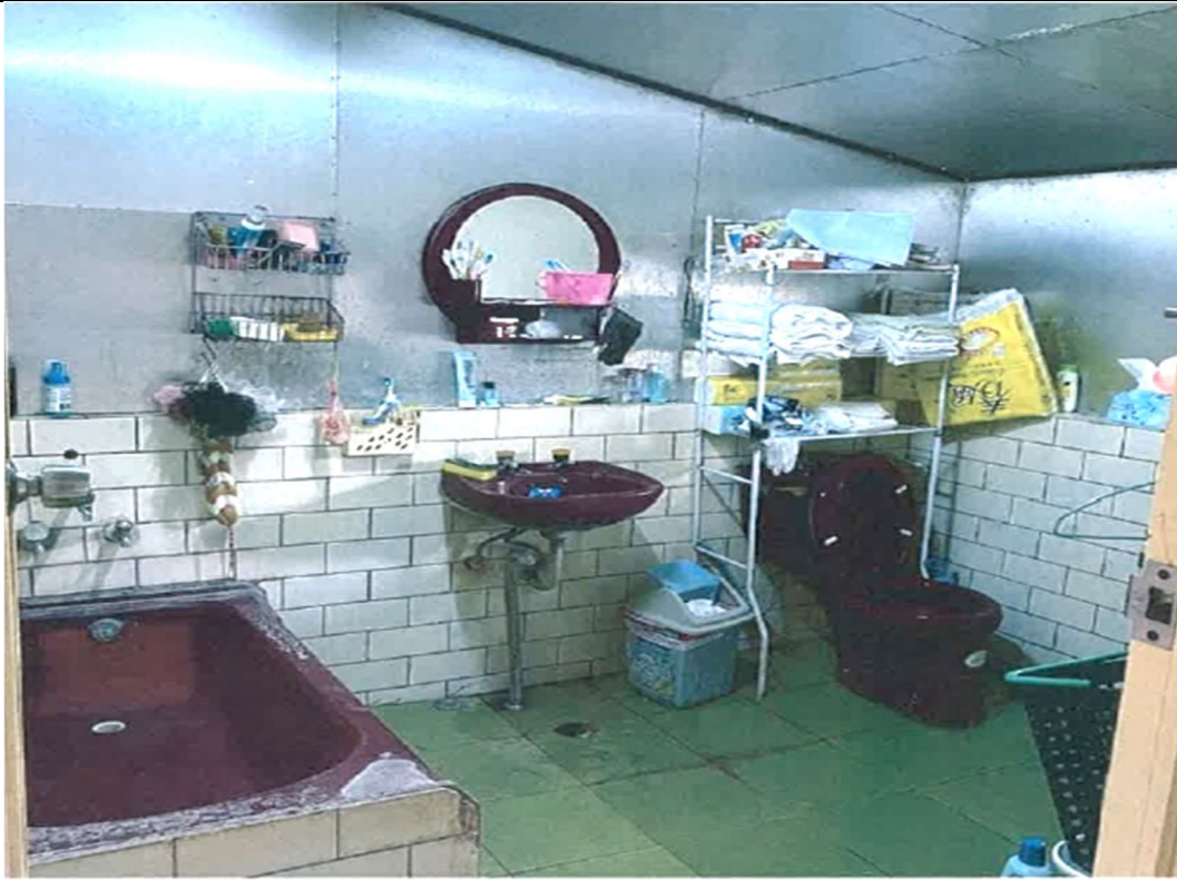
▲ 衛浴設施設備改善 (修繕前)
